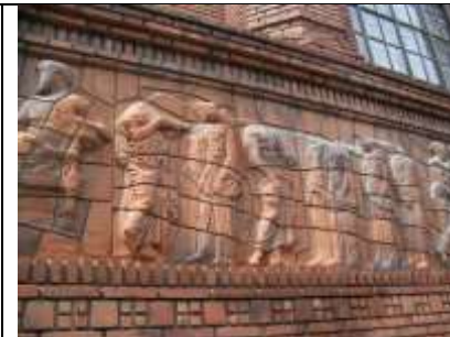
La frise couronnant le rez-de-chaussée
